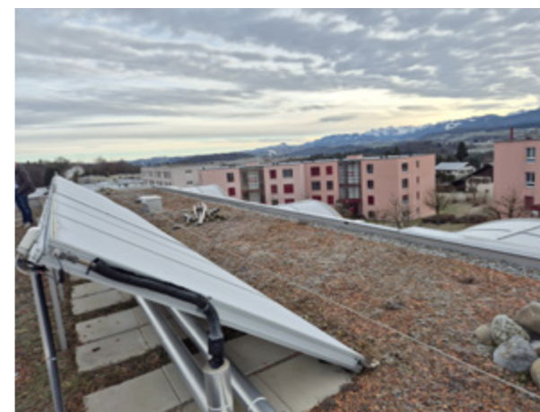
Dachfläche mit Solaranlage in Neyruz/FR. Die Dachanlage fördert die Biodiversität und die ökologische Nachhaltigkeit.
