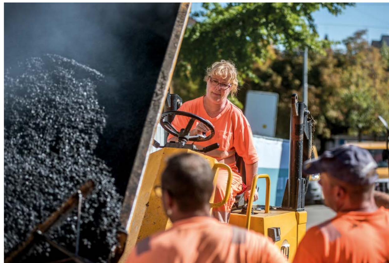
Fotoserie «Sanierung Kirchenfeldbrücke», 2018 © Alexander Egger
