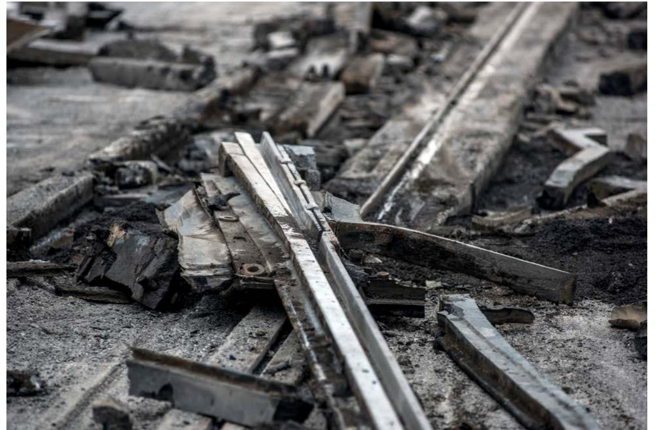
Fotoserie «Sanierung Kirchenfeldbrücke», 2018 © Alexander Egger
