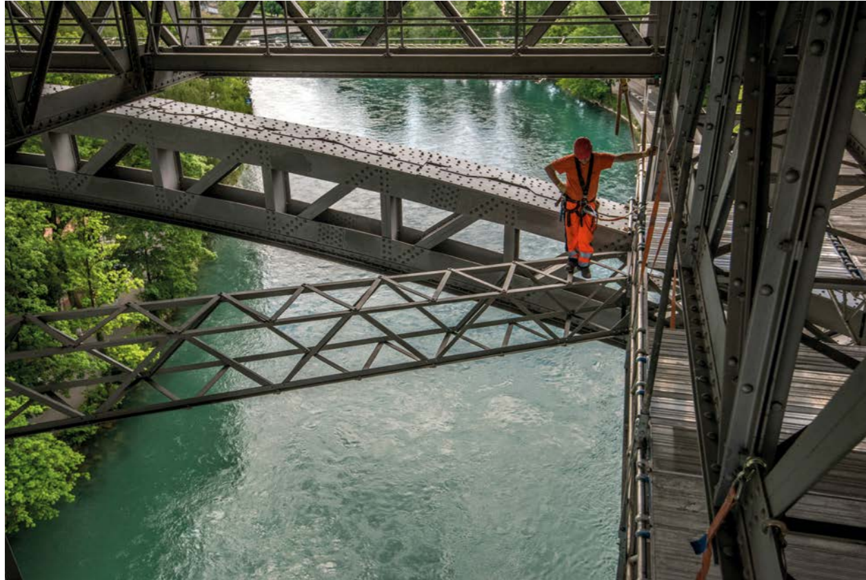
Fotoserie «Sanierung Kirchenfeldbrücke», 2018 © Alexander Egger
