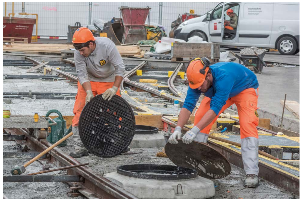
Fotoserie «Sanierung Kirchenfeldbrücke», 2018 © Alexander Egger
