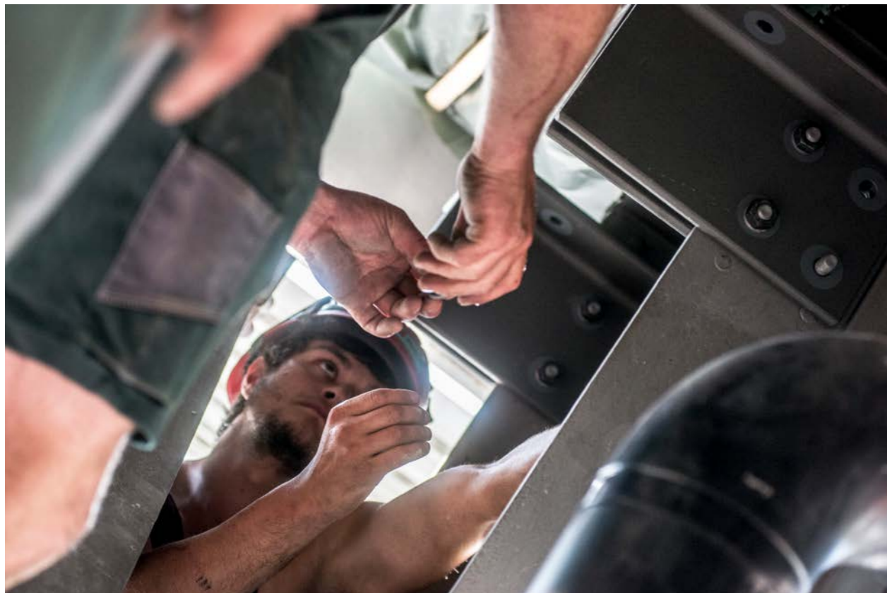
Fotoserie «Sanierung Kirchenfeldbrücke», 2018 © Alexander Egger
