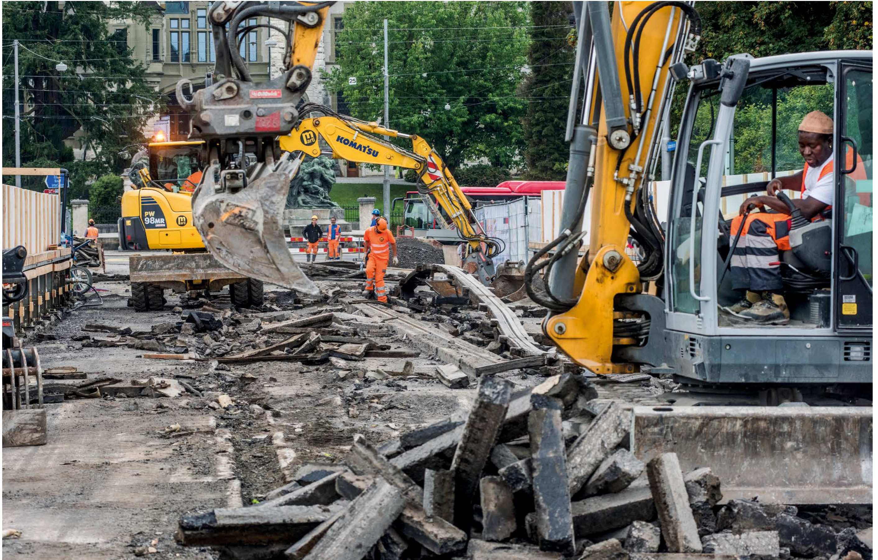
Fotoserie «Sanierung Kirchenfeldbrücke», 2018 © Alexander Egger
