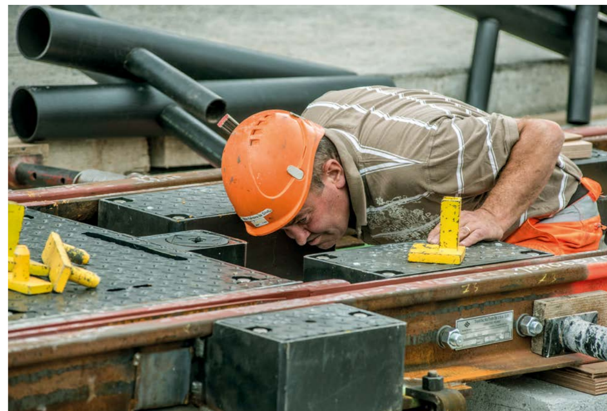
Fotoserie «Sanierung Kirchenfeldbrücke», 2018 © Alexander Egger
