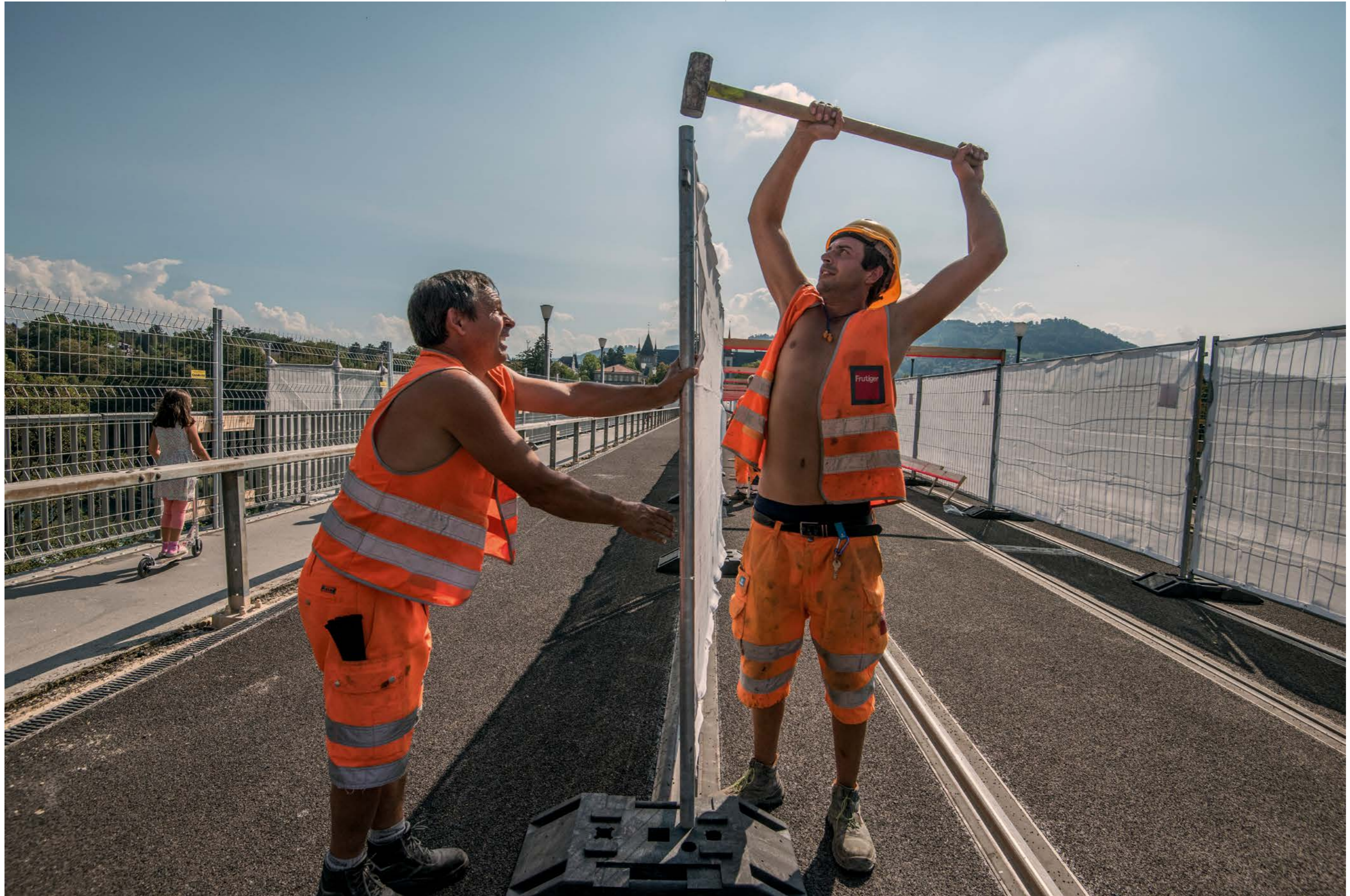
Fotoserie «Sanierung Kirchenfeldbrücke», 2018 © Alexander Egger
