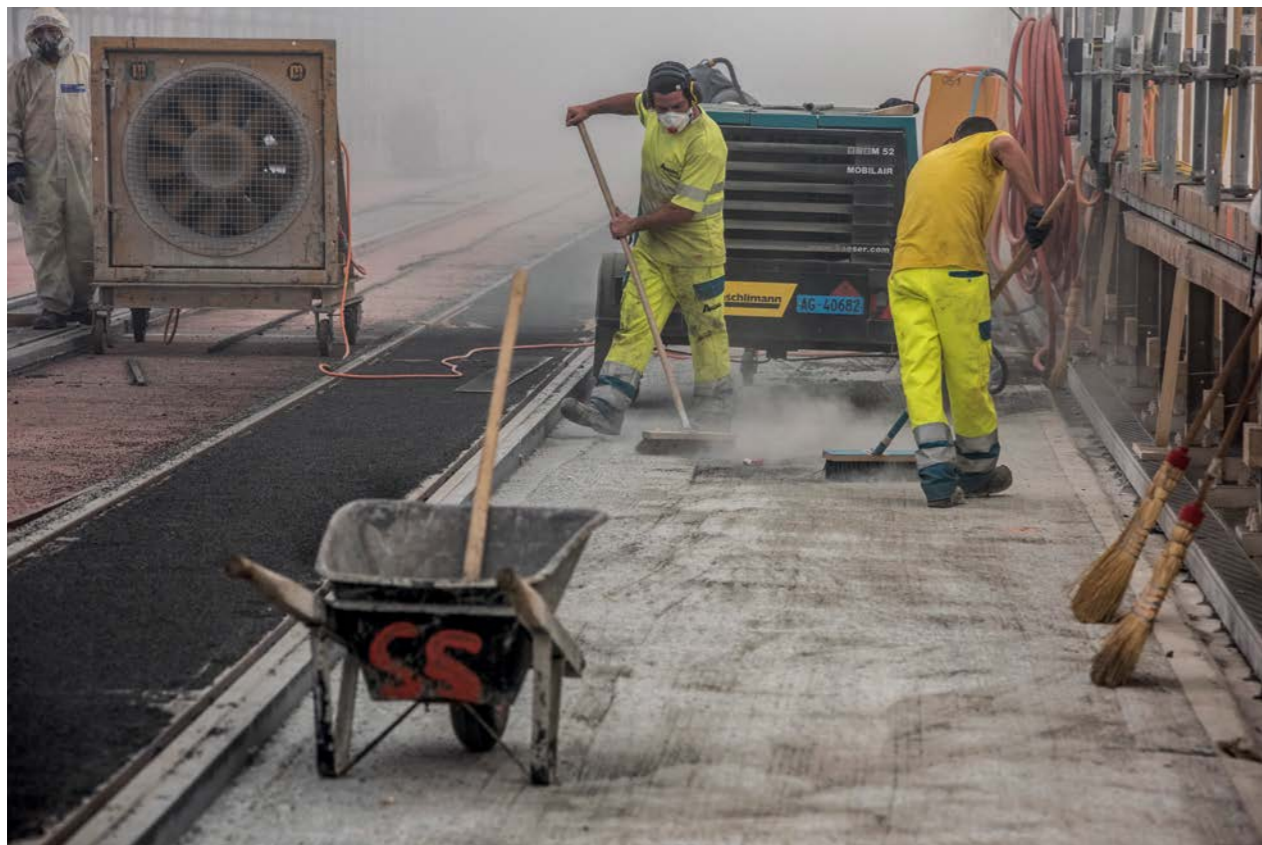
Fotoserie «Sanierung Kirchenfeldbrücke», 2018 © Alexander Egger
